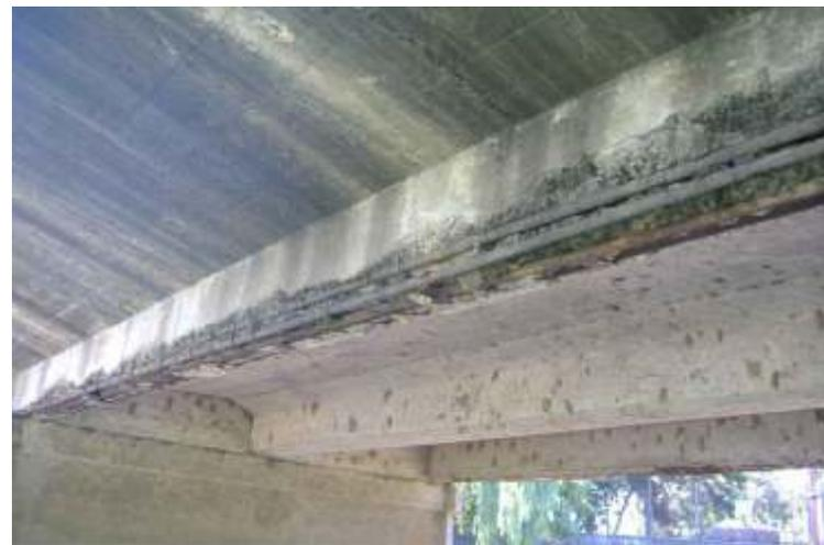
*Arenado y reconstrucción de recubrimientos*
